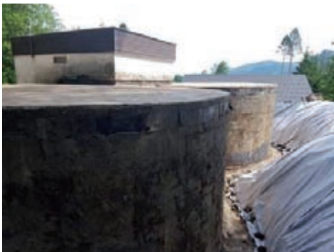
Die Hochbehälter wurden freigelegt und werden anschließend isoliert.
