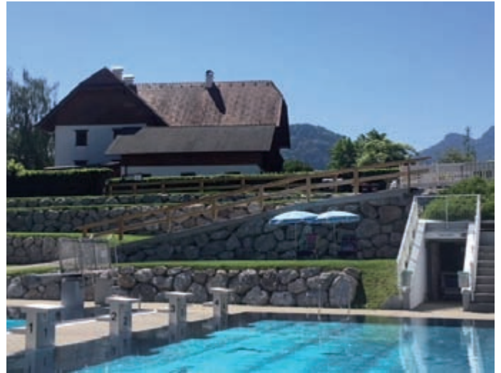
Die für Badegäste bereits gefährlich gewordenen Stützmauern wurden heuer durch eine Steinschlichtung ersetzt.
