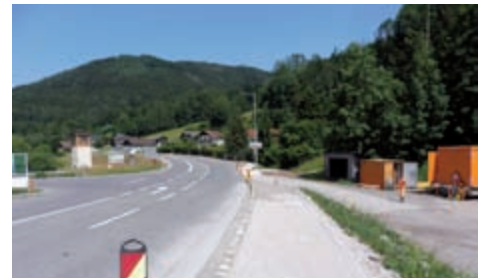
Der Gehsteig und die Bushaltestelle kurz vor der Fertigstellung.
